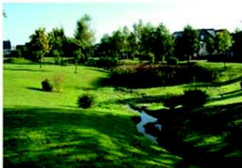
Noue et bassin d'orage - ZAC Portes de la forêt Bois-Guillaume - CAUE 96
